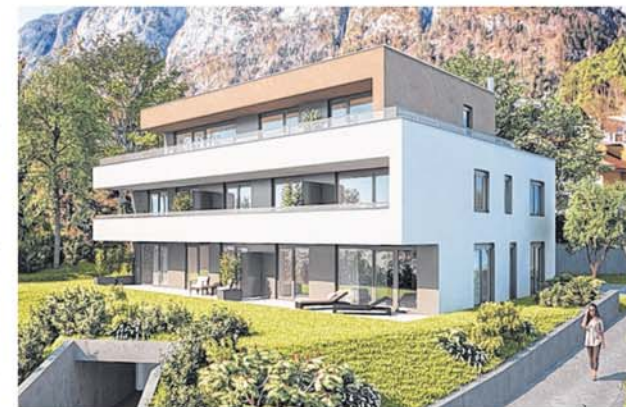
Das Wohnprojekt „Kranebitten“ lässt Raum zum Mitgestalten. In sonniger Aussichtslage verwirklicht sich der maßgeschneiderte Wohnwunsch in 6 bis 7 Wohneinheiten.
